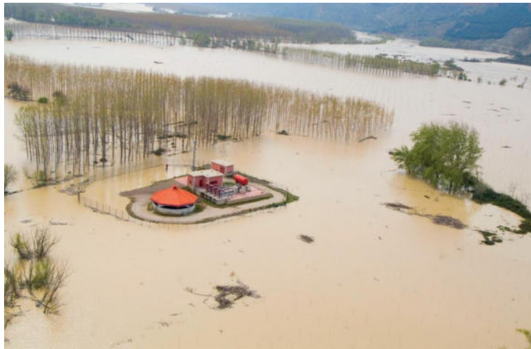
Figura 28. Estación de bombeo sobreelevada, inundaciones de 2013 en Funes (Navarra)
