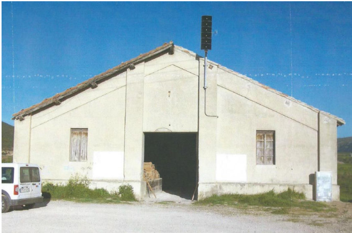
Figura 22. Sirena de la CHE situada en Liédena para avisos en el escenario 3 de la presa de Yesa
