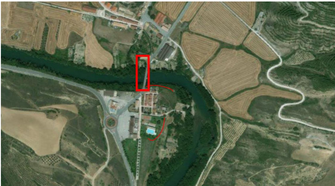
Figura 23. Medidas estructurales: puentes y protección longitudinal
