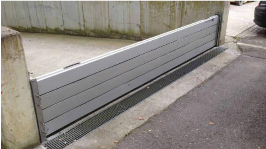
Figura 26. Puerta de cierre estanca modular que ofrece solución de continuidad al muro de cierre, montada dentro de dos perfiles en U ancladas en una pared
