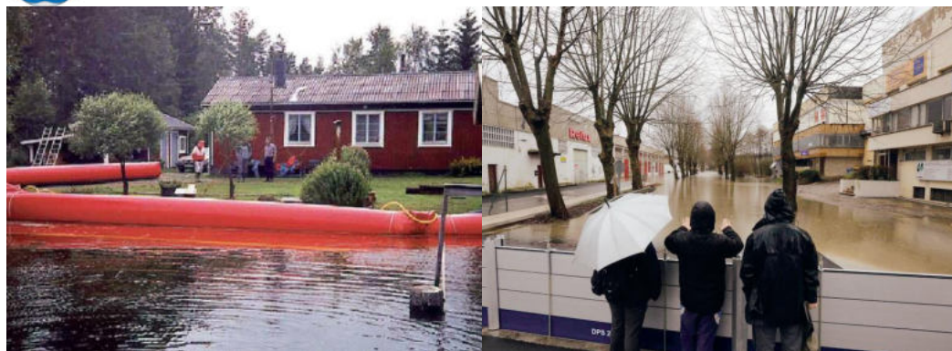
Figura 29. Izq.: Barreras anti-inundación temporal de contención móvil con sellado hermético. Dcha.: Barras de protección modular anti-inundación de instalación temporal, con placas de anclaje y perfiles preinstalados hormigonados
